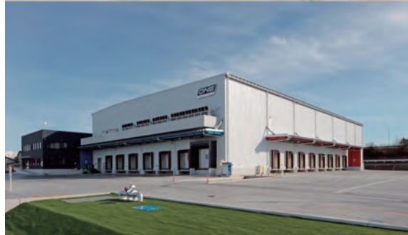
富山西 TC (冷凍冷蔵倉庫) [富山県]
